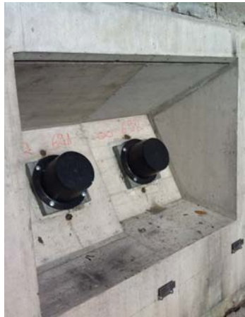
Einfüllen SV-Beton durch best. Öffnungen Ankerhauben
