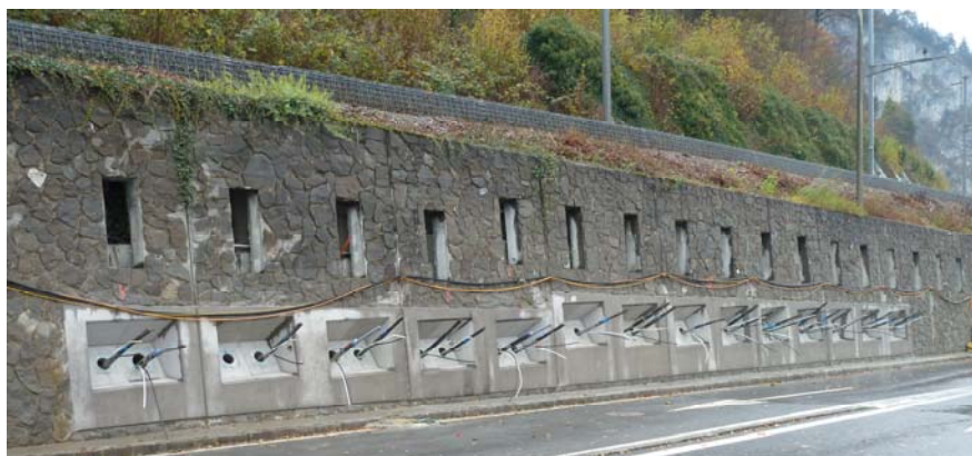
Neue Longarine mit eingebauten Anker (vor Ankerprüfung); Hinter Öffnungen oben bestehende Longarine und alte Anker; Oberhalb Bahn, unter dem Efeu, liegen die verankerten Ankerplatten
