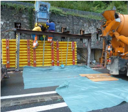
Einfüllen SV-Beton durch best. Öffnungen Ankerhauben
