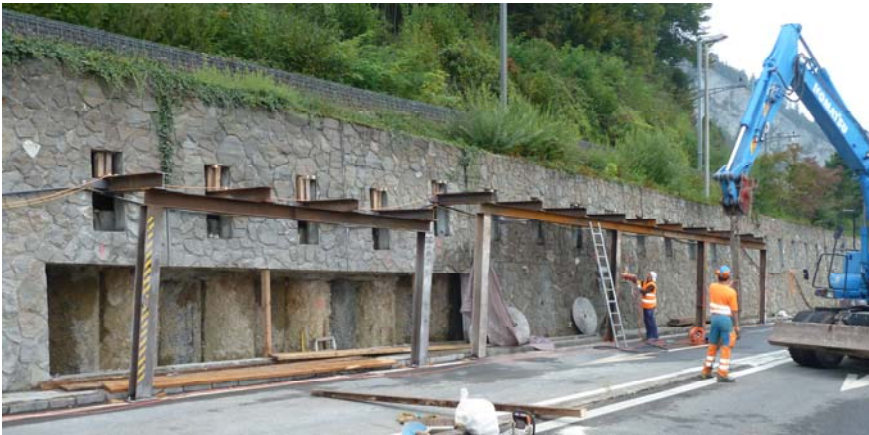
Teilabbruch Steinverkleidung mit temporärer Abstützung; bestehende Bohrpfähle mit Sickerbetonausfachung sichtbar
