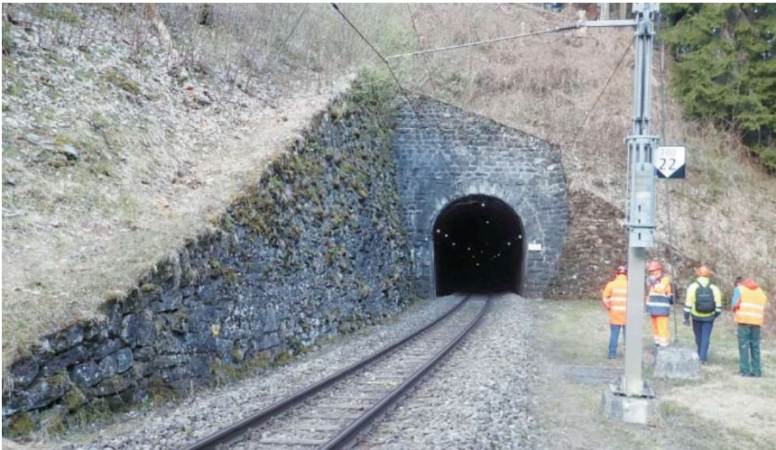
Ansicht Portalbereich Solis des Versascatunnels. Links vom Gleis ist die bestehende Natursteinmauer zu sehen. Diese wird mit einer Schwergewichtsmauer ersetzt. Die neue Mauer wird ca. 2 m bergwärts verschoben. (Foto aus Geologischem Prognosebericht, BauGrundRisk GmbH)
