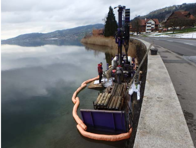
Installation des Bohrgerätes im Aegerisee
