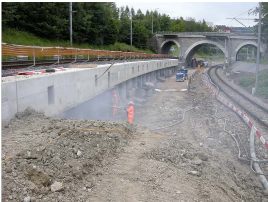
Ausfachungsarbeiten an der Pfahlwand. Oben SOB-, rechts SBB Trasse
