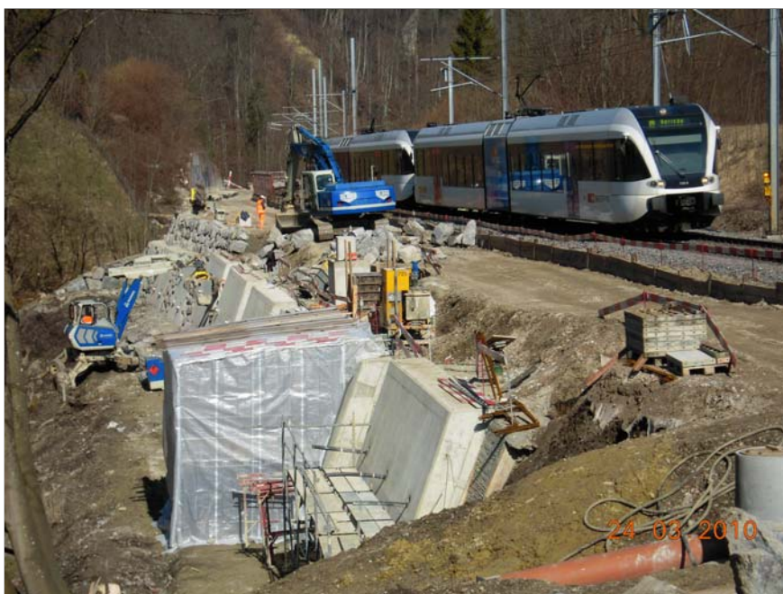
Erstellung Hangsicherung im latenten Kriechhang. Rechts SBB Trasse
