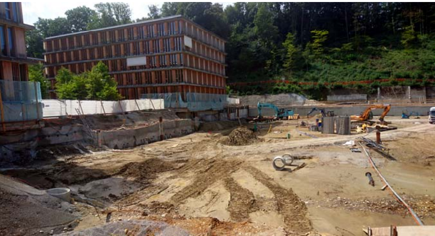
Baugrubenaushub neben den Gebäuden
