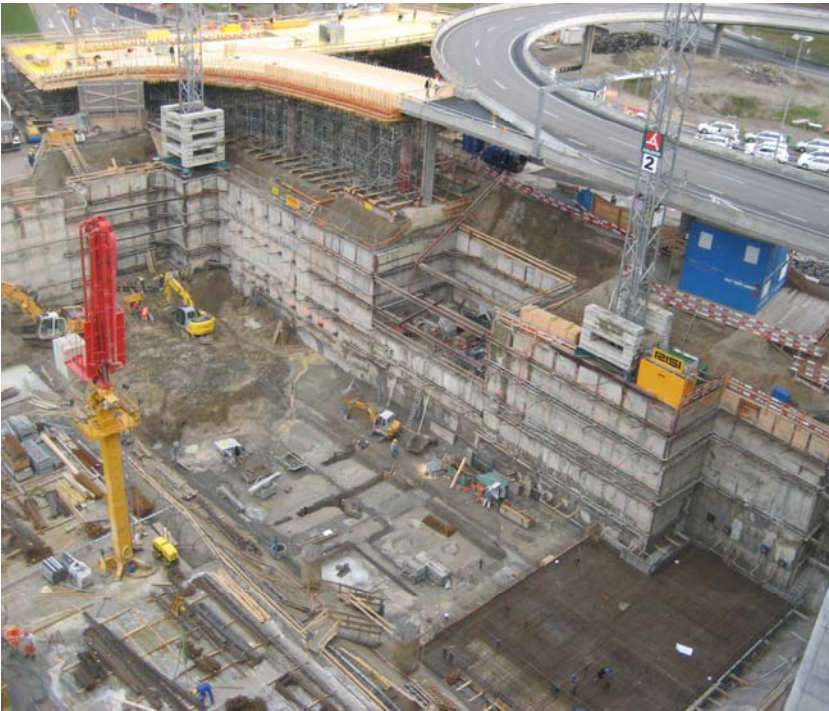
Letzte Aushub- und Ausfachungsetappe ca. 16 m unter Terrain
