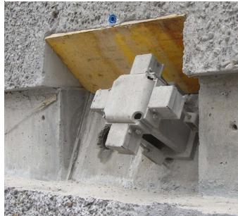
Sicherung der bestehenden Anker mit ABOXX.
