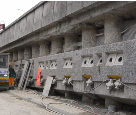
Wandverkleidung (Betonelemente) entfernt, Einbau der Ersatzanker
