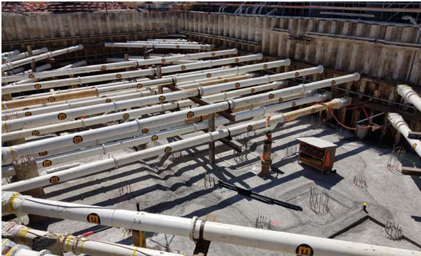
Übersicht Baugrube, Endaushub erstellt.
