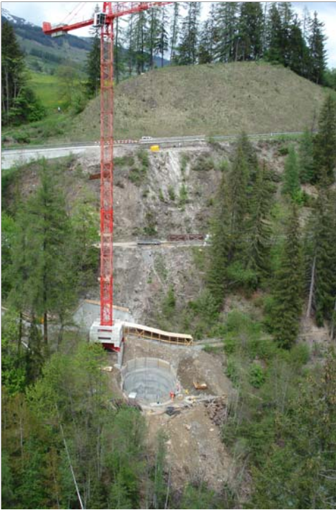
Blick auf Pfeilerschacht Scuol und Widerlagerseite Scuol. Oben im Bild die Engadinerstrasse
