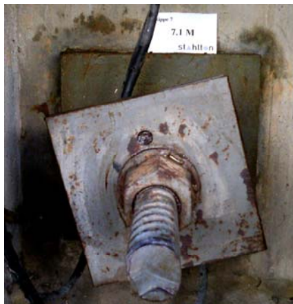
Visuelle Überwachung Freihof – Passmal (Bild Stahlton AG)
