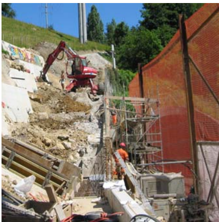
Erstellung der Ankerriegel und Zugbalken beim Südportal
