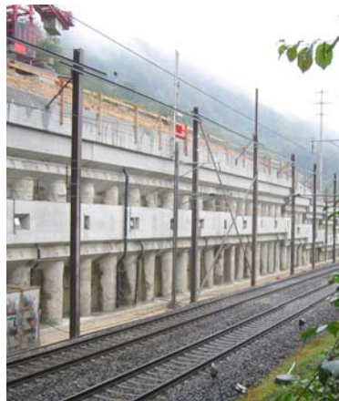
Stützwand Nord nach Fertigstellung
