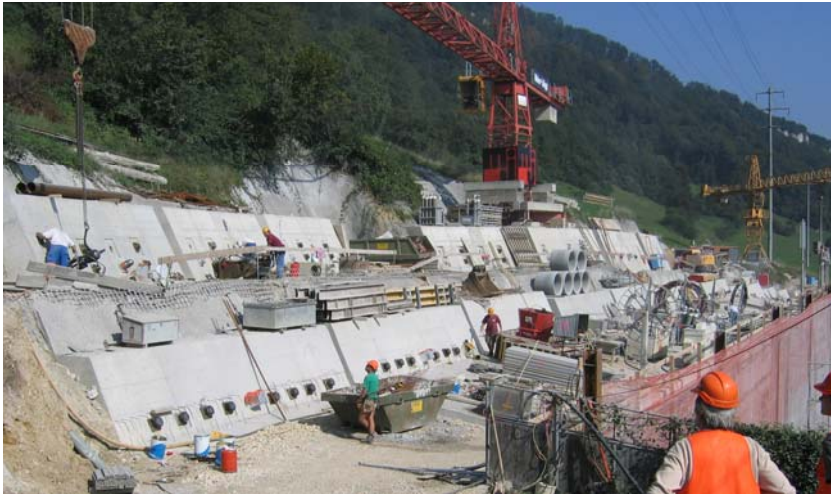
Erstellung der Ankerriegel beim Nordportal
