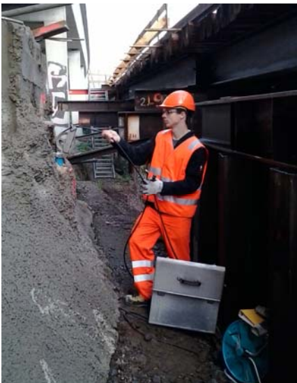
Inklinometermessung zwischen Hilfsbrücke (rechts) und Verankerung des Pfeilers der bestehenden Brücke.
