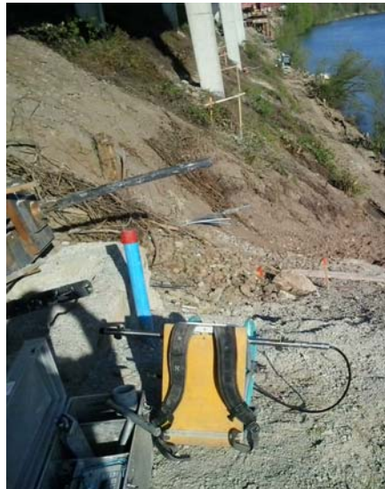
Inklinometer bei Pfeiler 1 in steilem Gelände. Links die Verankerung der bestehenden Brücke. Vor Bau der Hilfsbrücke
