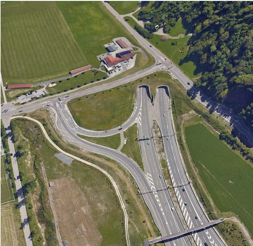
Portalbereich Nord Islisbergtunnel (Ausschnitt Google Earth)
